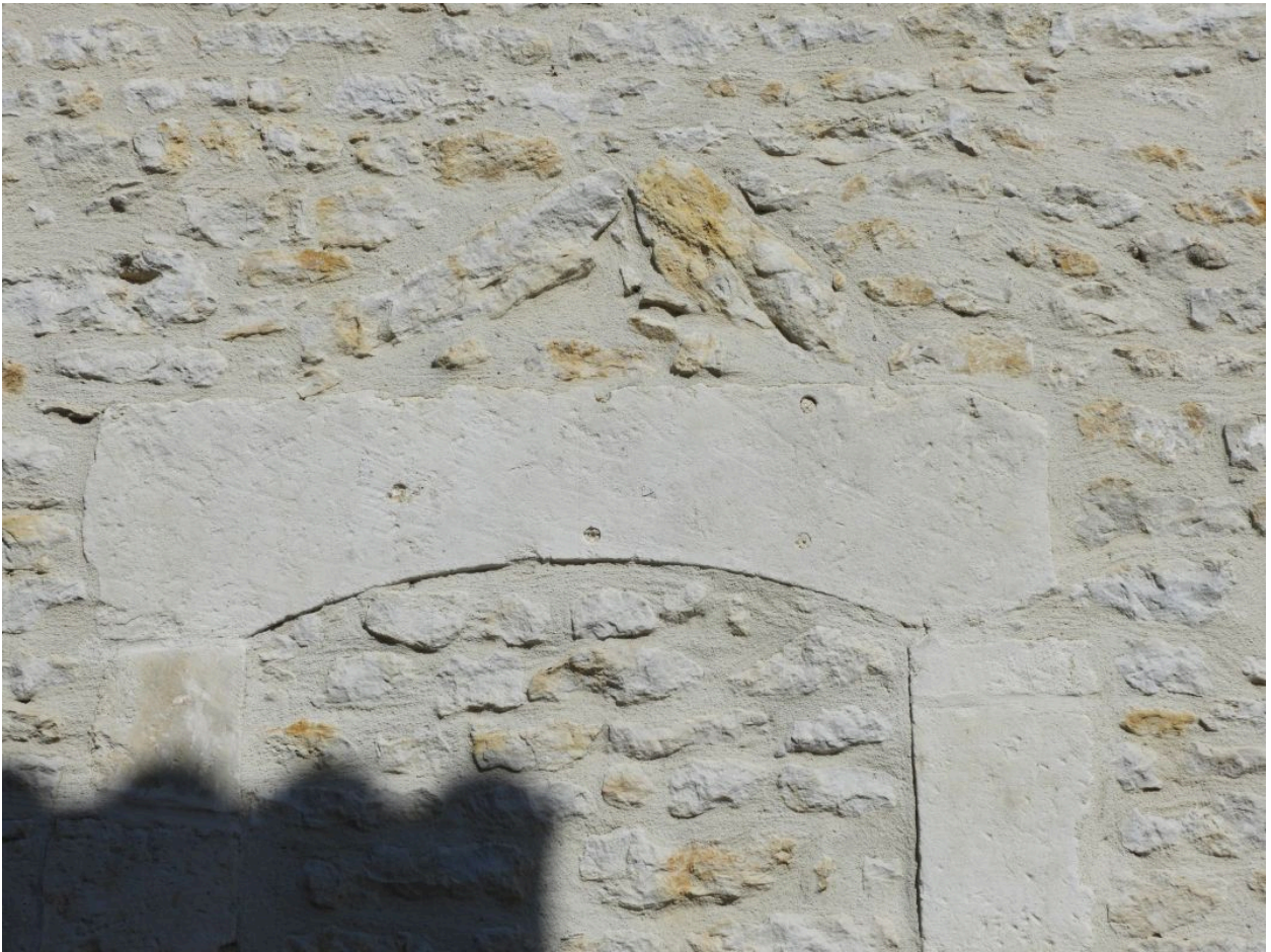
Ancienne ouverture murée, avec linteau en arc segmentaire et arc de décharge.
