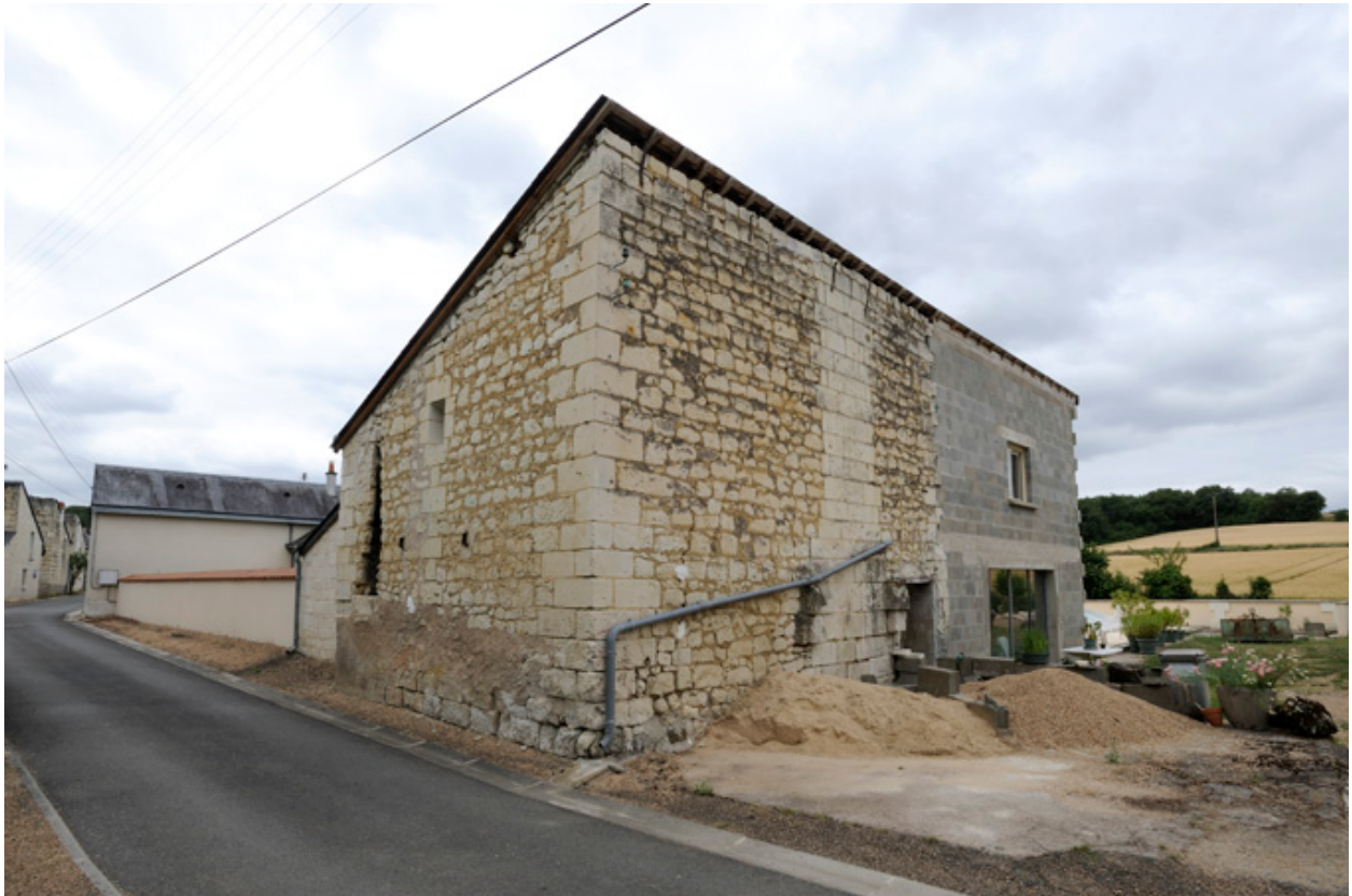
Maison du 88, rue des Potiers : maison en appentis, avec cheminée de type troglodytique dans le mur sur rue.
