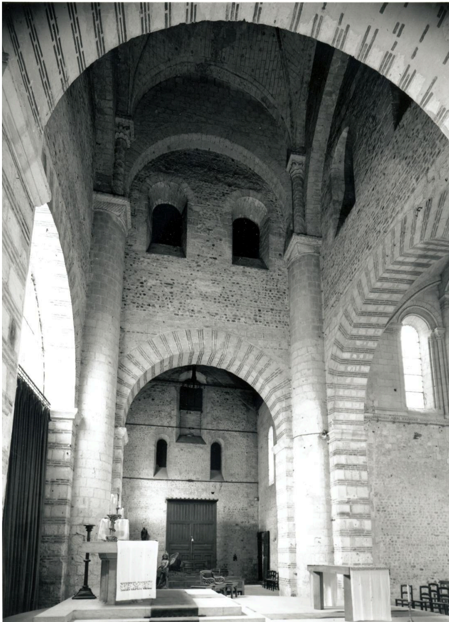
Croisée et bras nord du transept sud : vue d'ensemble.
