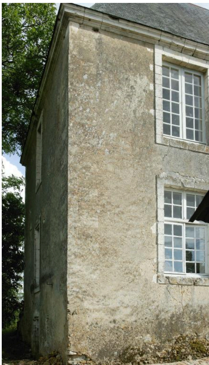
Corps de logis du XVIIIe siècle, angle nord-est : détail du décor de faux-appareil incisé dans l'enduit et de l'imitation de chaîne d'angle.
