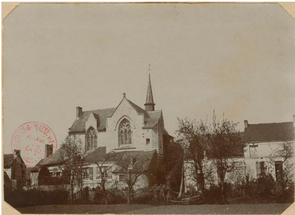
L'église Notre-Dame de Béhuard. Vue prise du côté sud. Photographie NB.
