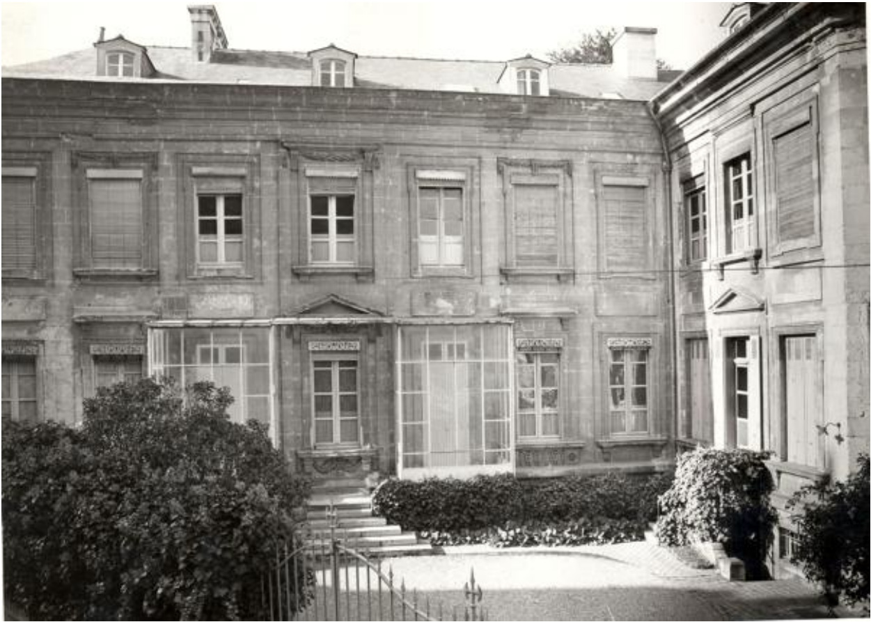
Corps principal et aile droite : élévations antérieures, sur cour.
