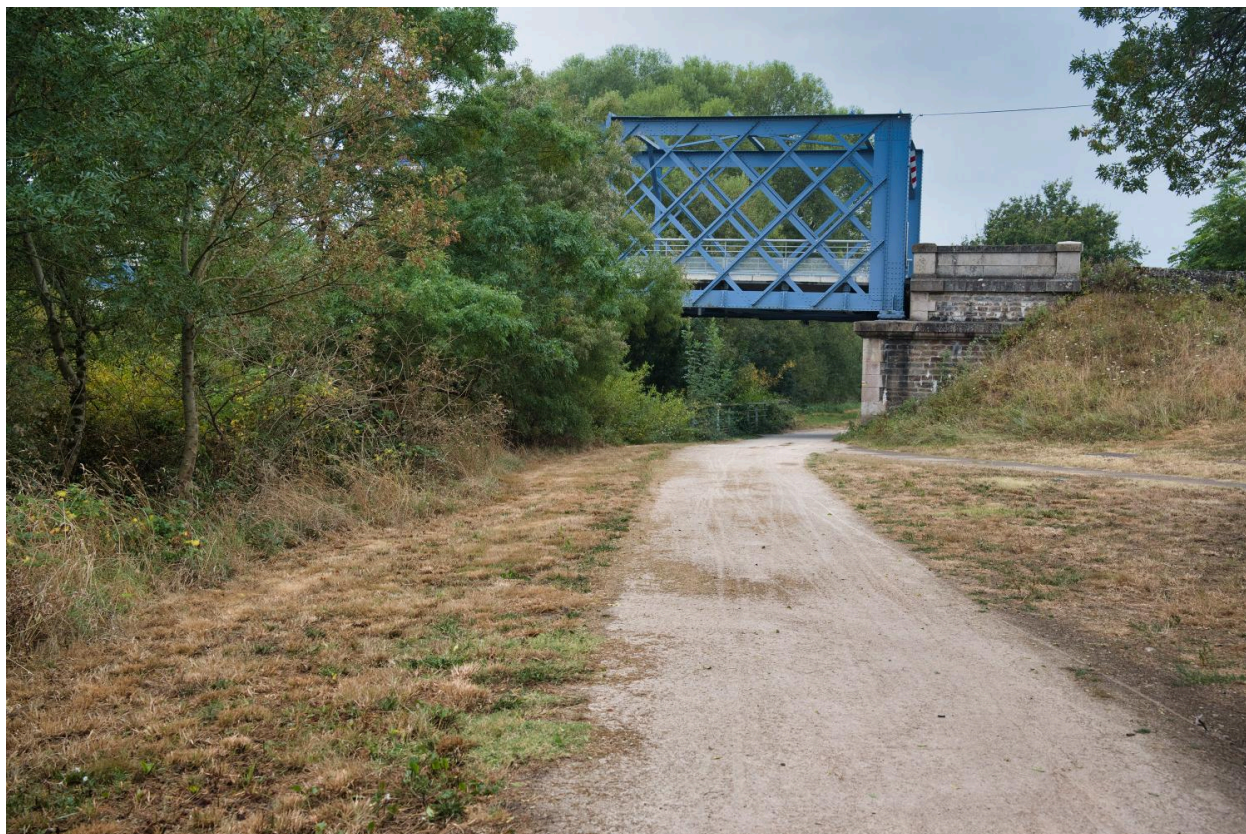
Le Grand Pont de Thouaré enjambant le chemin de halage en rive nord.
