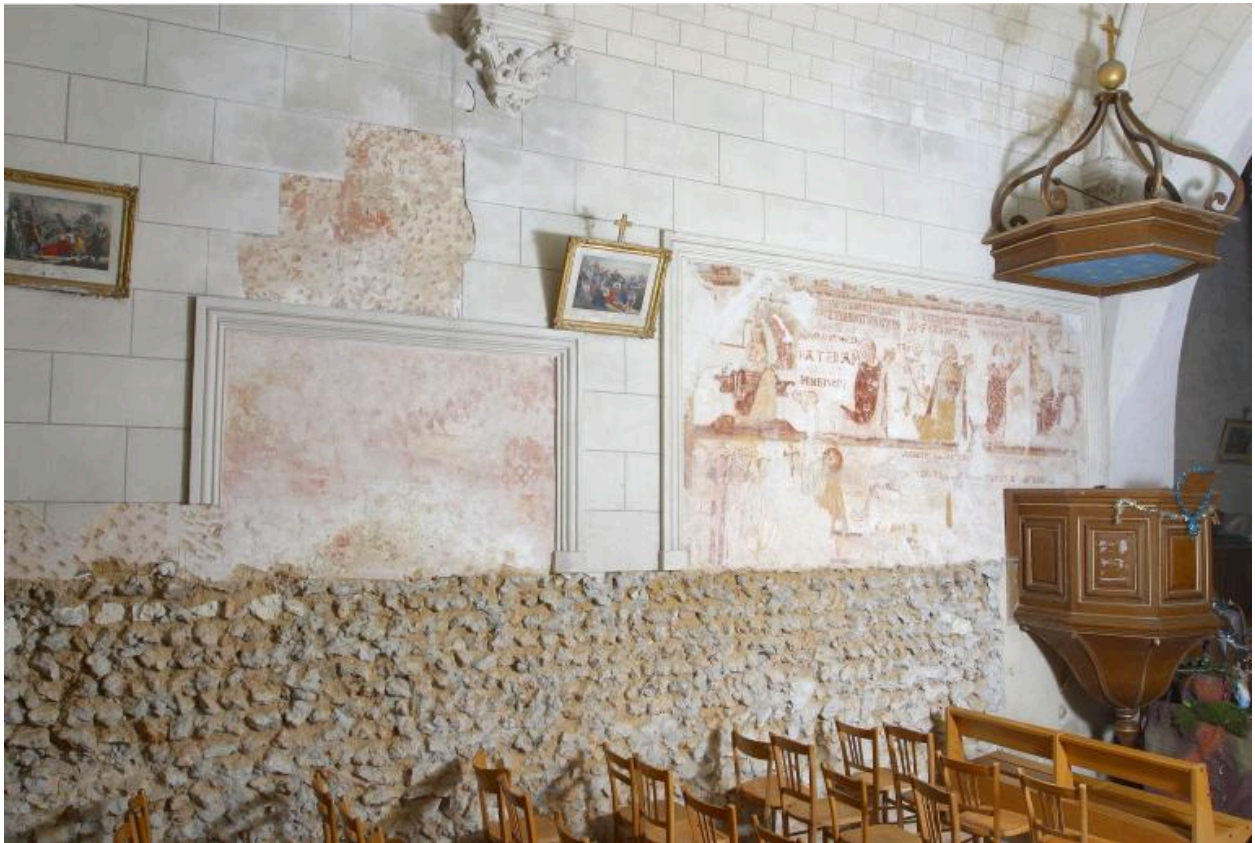
Nef, mur nord : vue d'ensemble des peintures romanes et gothiques.
