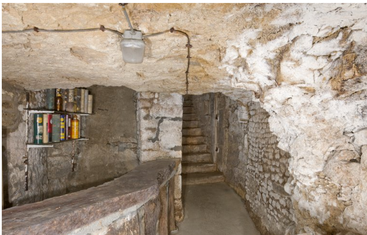
Vue du deuxième niveau de sous-sol.
