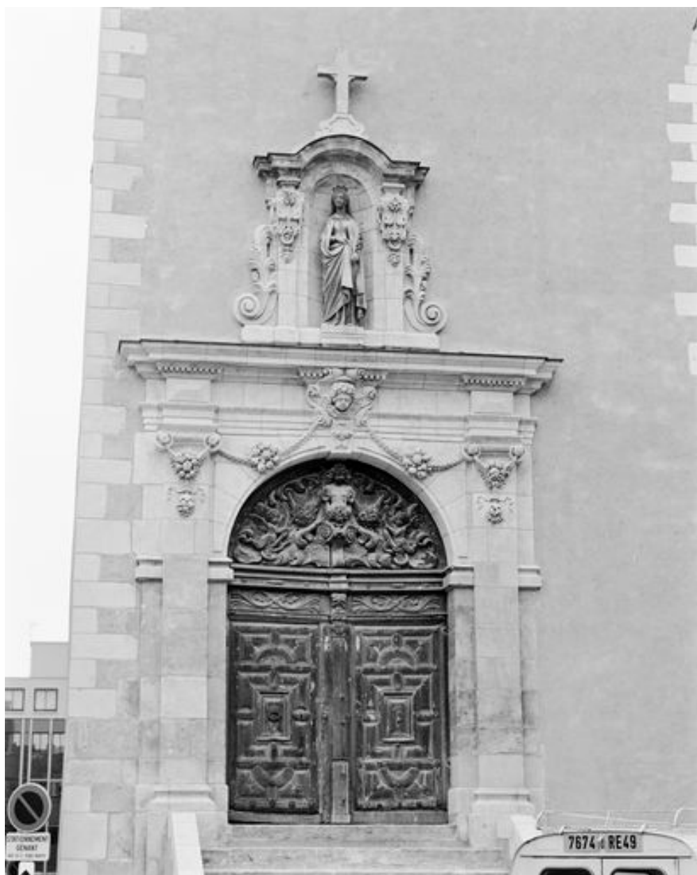
Eglise conventuelle, mur sud : porte d'entrée.
