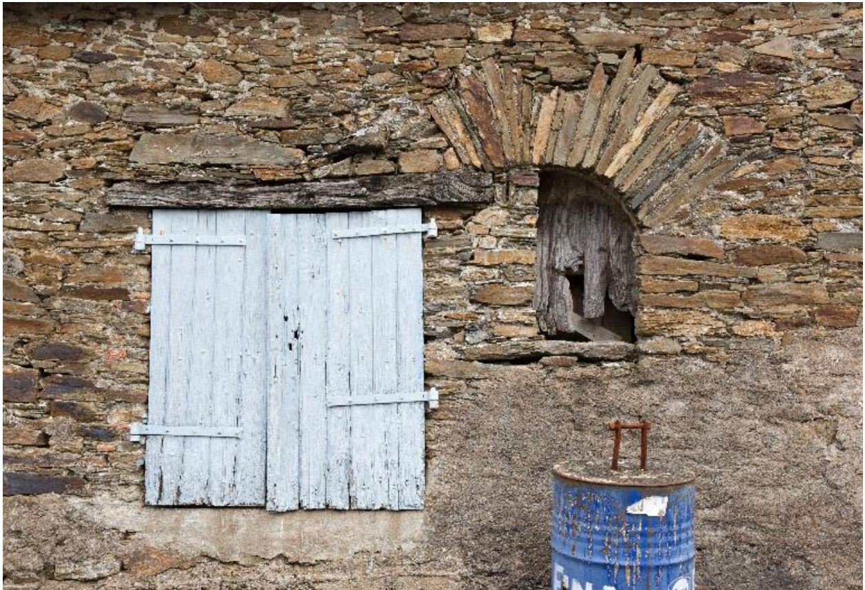
Façade avec baie remaniée, D01-306, cadastre 2018.
