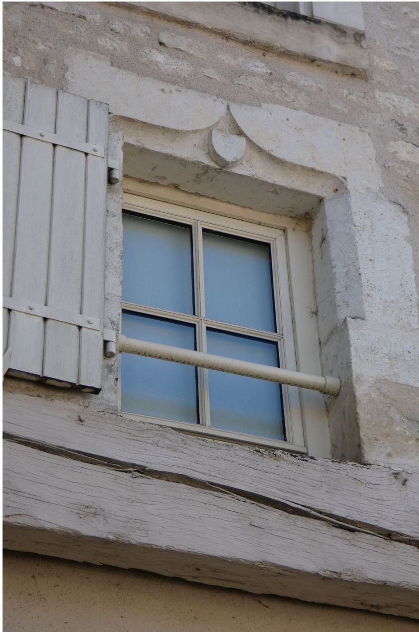
La baie avec linteau en accolade, au-dessus du passage couvert.
