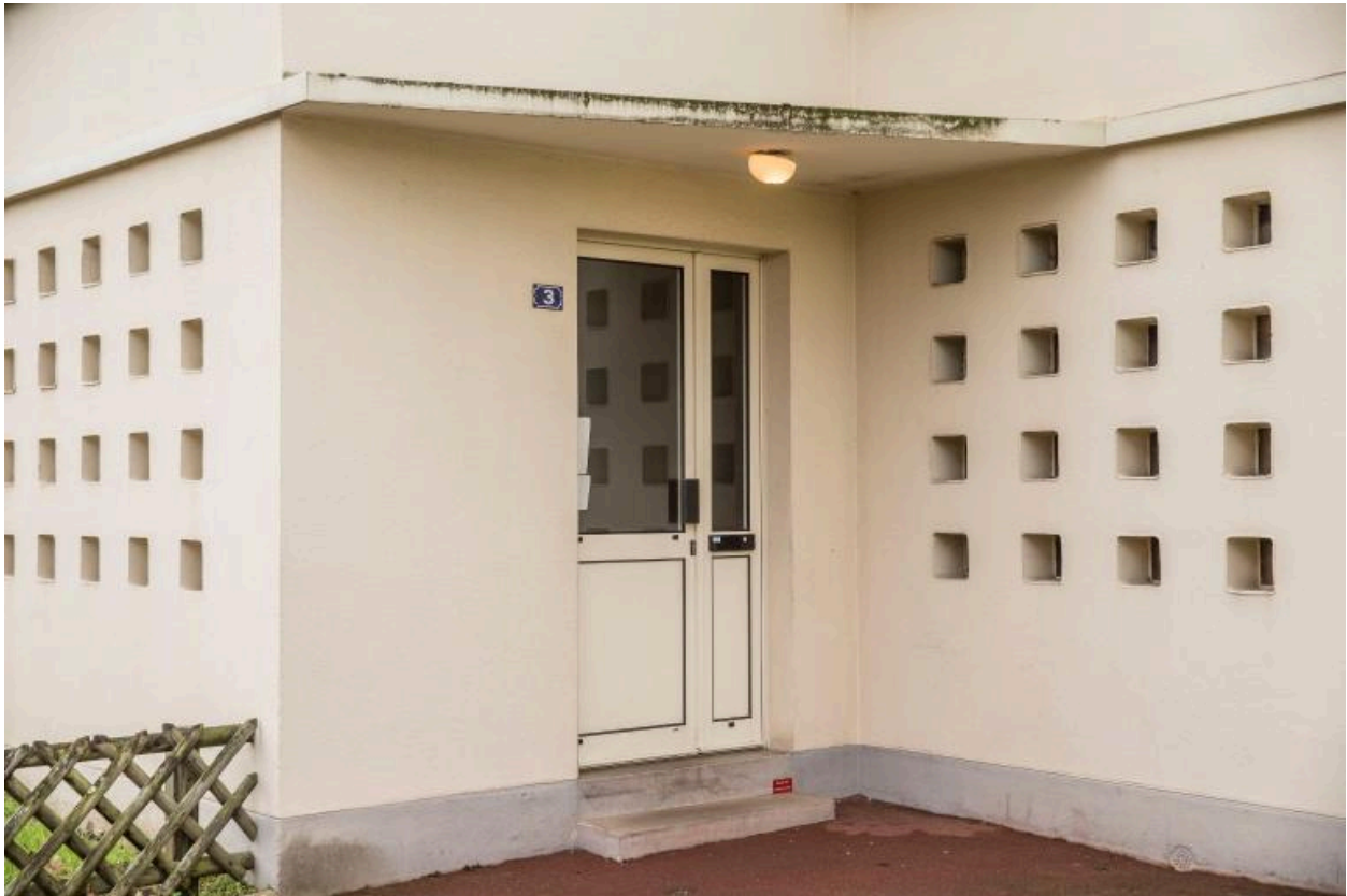
Vue d'une des portes d'entrée de l'immeuble.
