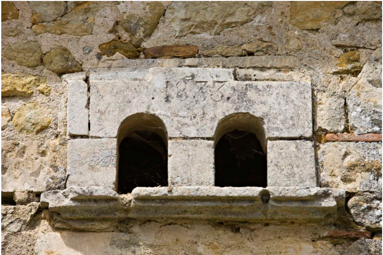
Détail de l'élévation antérieure.
