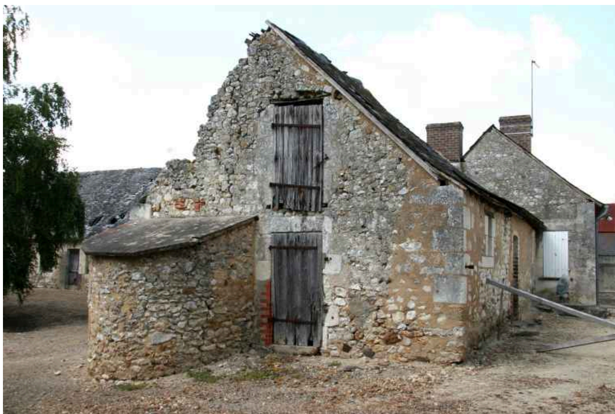
Maison 5, dépendances : pignon avec four.
