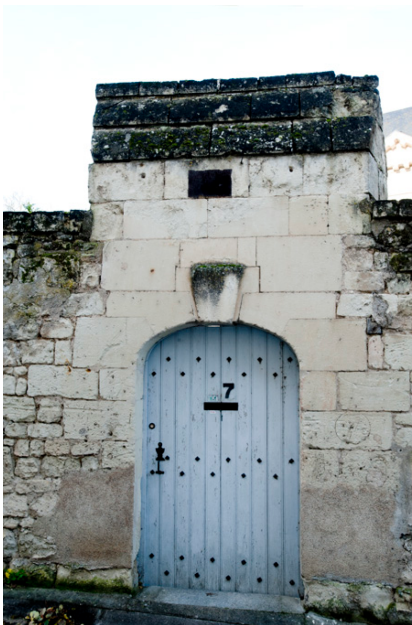
Porte piétonne à arc en anse de panier, clef saillante et pendante et crossettes en escalier (porte la date de 1762), dans le mur de clôture, rue Jeanne d'Arc.
