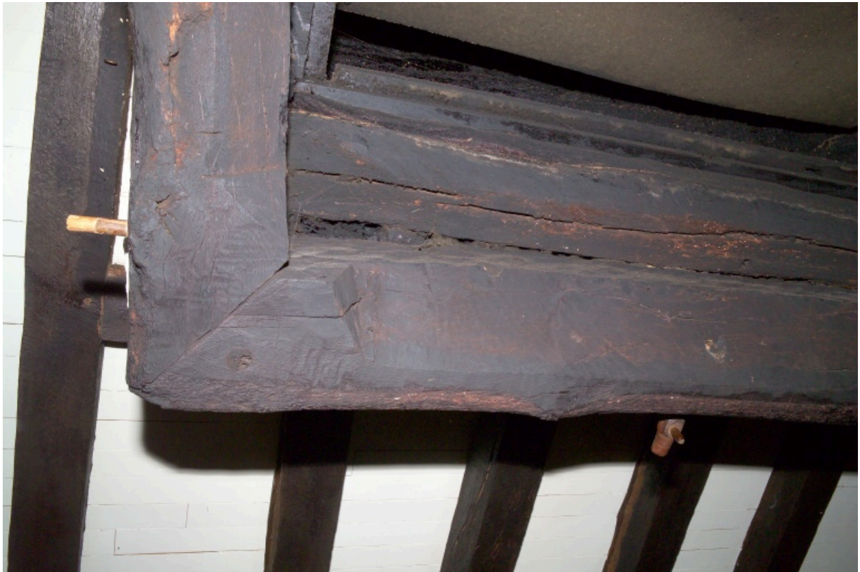
Cheminée du pignon est, détail du chanfrein sur le linteau.
