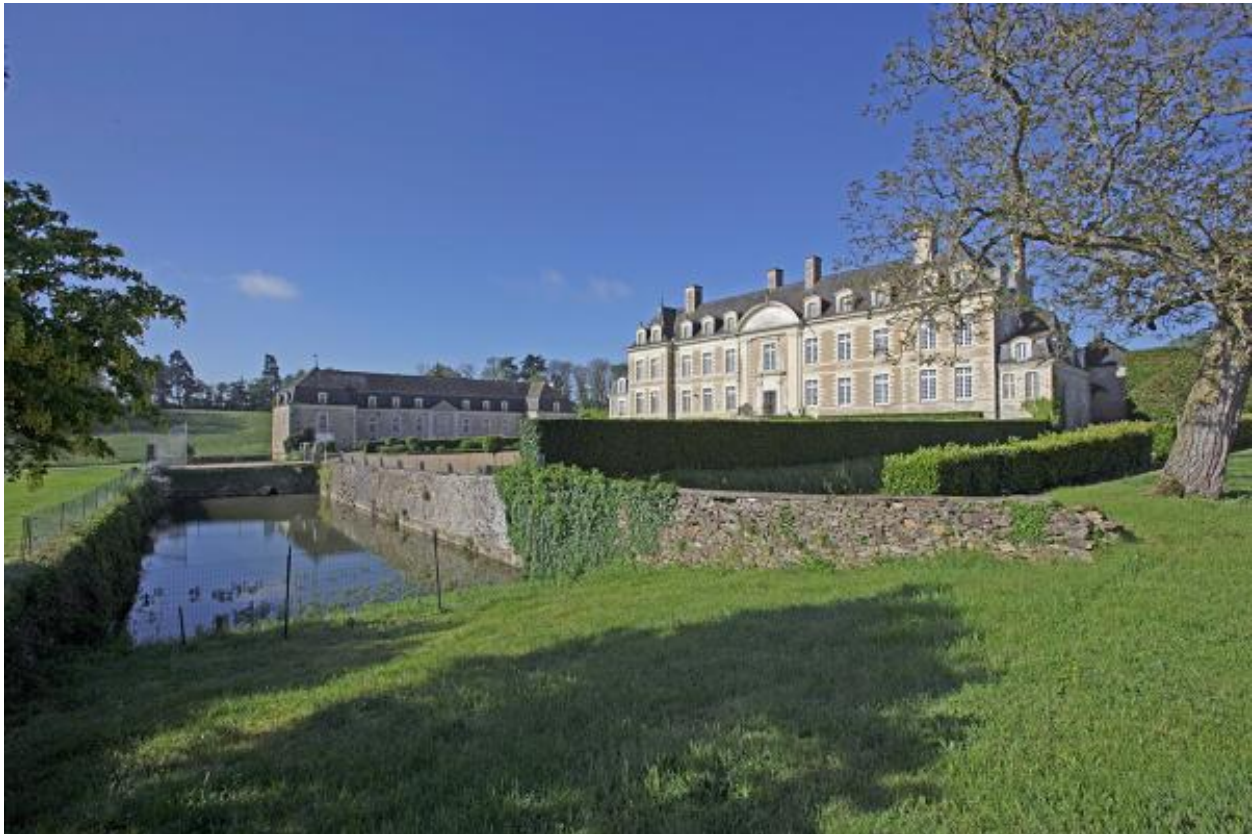
Une vue d'ensemble du corps de logis et du grand commun depuis le nord-est.
