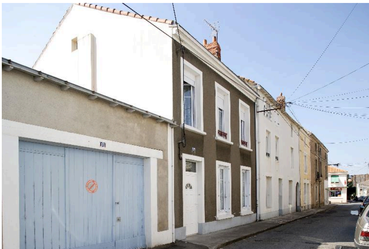
Vue de la façade sud de la rue du Faisan depuis la maison n° 15 vers la place du Marché.
