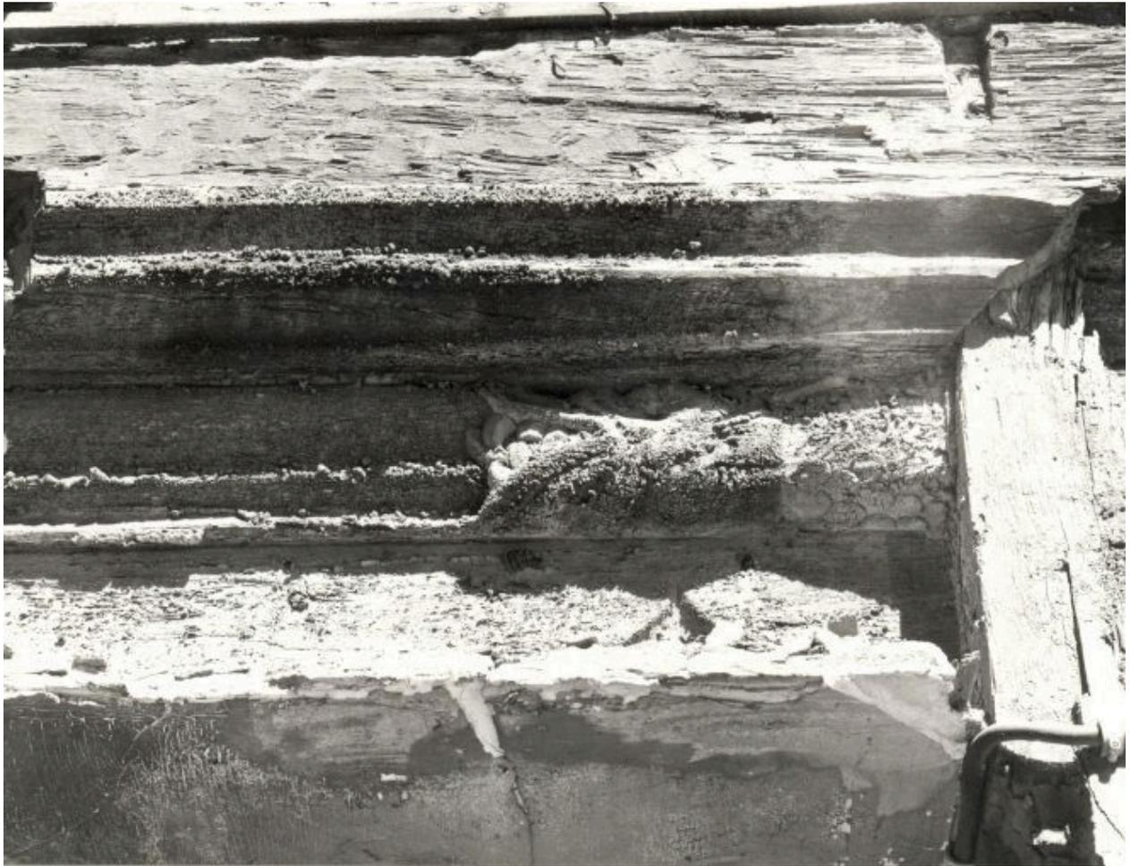
Elévation antérieure, 1er niveau : sablière de plancher, engoulant de droite.
