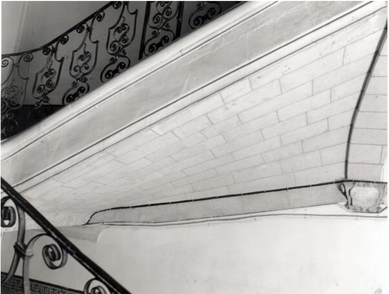
Aile nord du cloître, extrémité est : escalier d'honneur, voûte de la deuxième volée.
