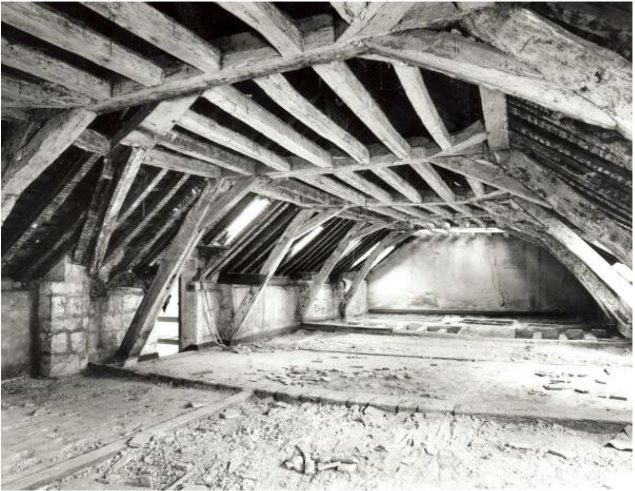
Corps principal, charpente : vue d'ensemble, en axe est-ouest. A gauche, issue vers le couvrement de l'escalier. Etat avant les travaux de restauration 1997-1998.
