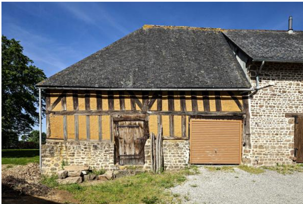
Façade orientale de la grange.
