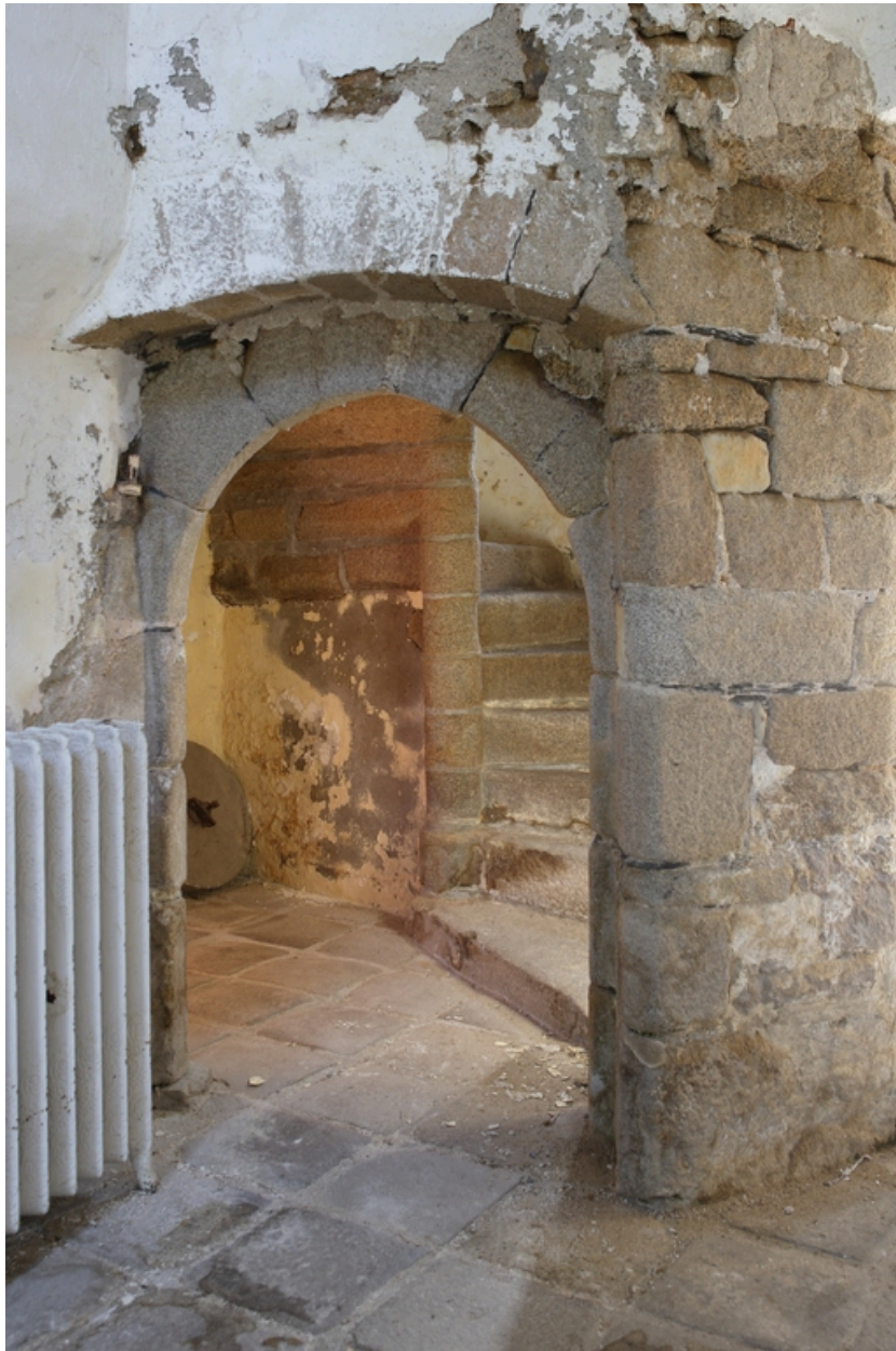
Aile est. Salle nord. Détail de la porte d'accès à l'escalier.
