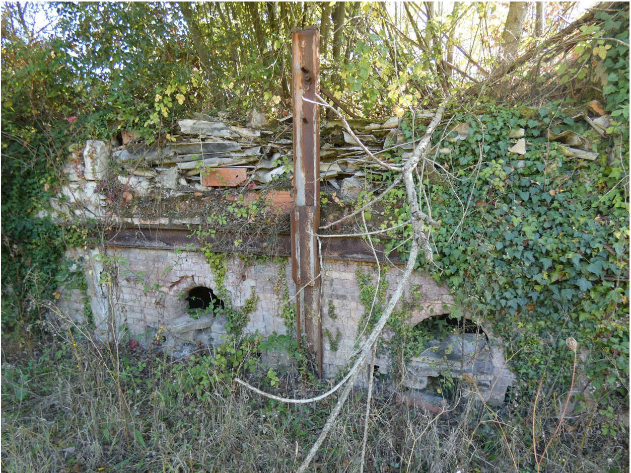
Les gueules de foyers du second four, vues depuis le nord.
