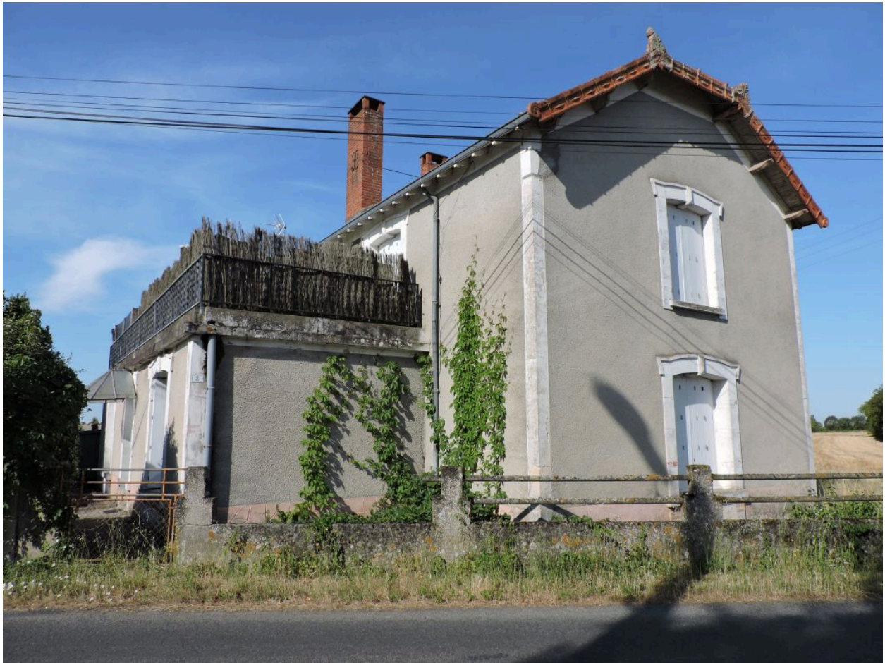
Le logis vu depuis le nord-est.
