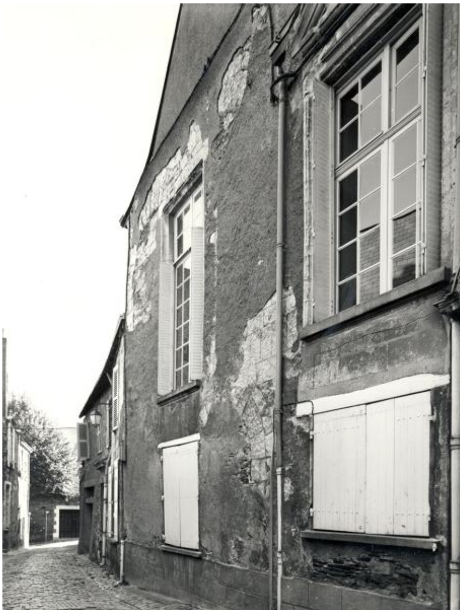
Vue d'ensemble sur rue depuis le sud avec le pignon sur rue du logis principal Xlle s. au 1er plan.
