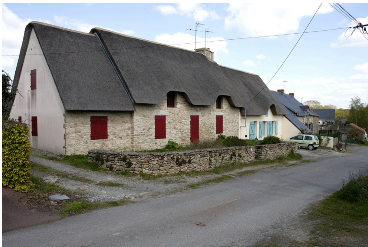
Vue de la rangée depuis l'ouest.
