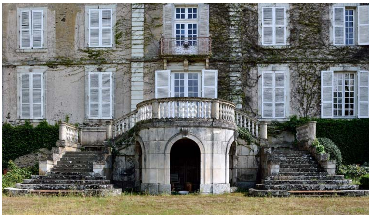
Mantelon. Château. Détail de l'escalier de la façade ouest.
