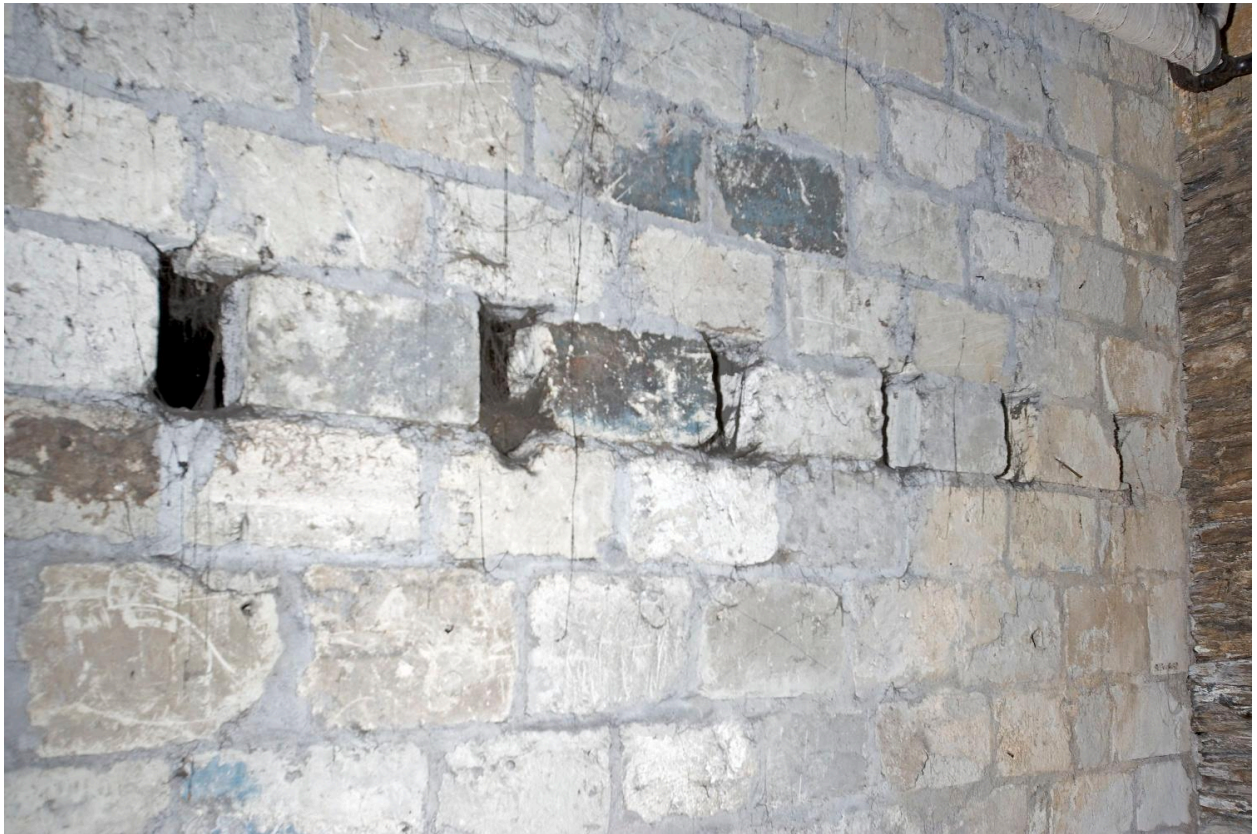
Corps de bâtiment du petit séminaire, sous-sol : cave 6, face postérieure en mur mince de tuffeau, avec ouvertures d'aération.
