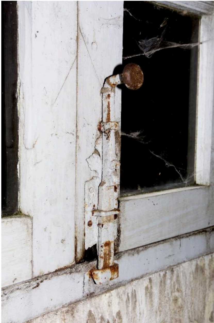
L'escalier, détail de la baie du premier étage.
