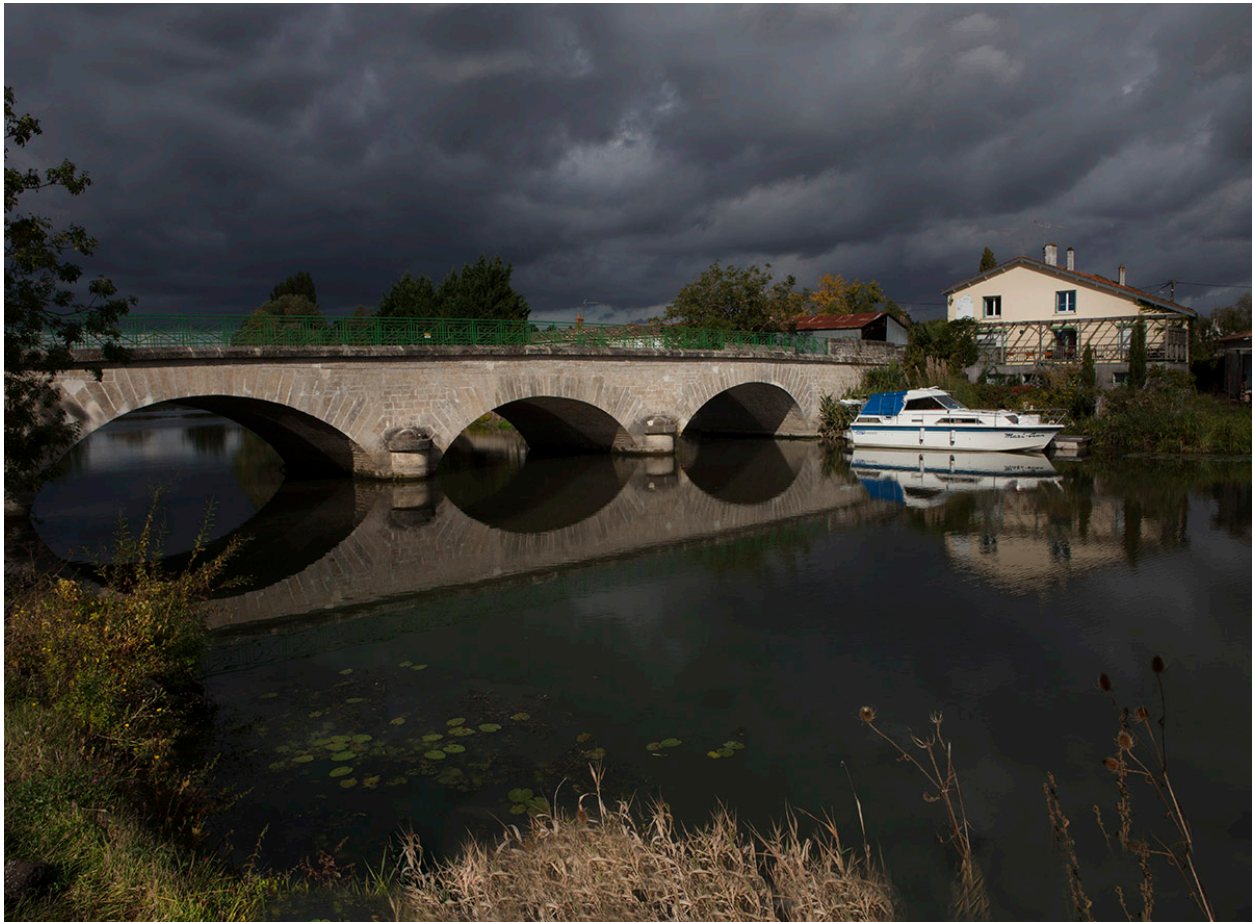
Le pont vu depuis le sud-est, côté amont.
