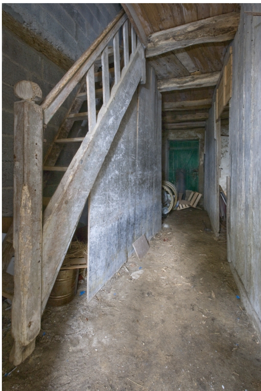
N° 10 rue Basse. Escalier.
