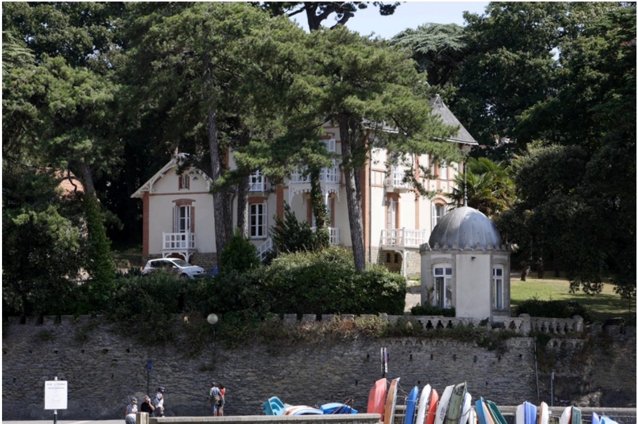
Vue d'ensemble, depuis le port.
