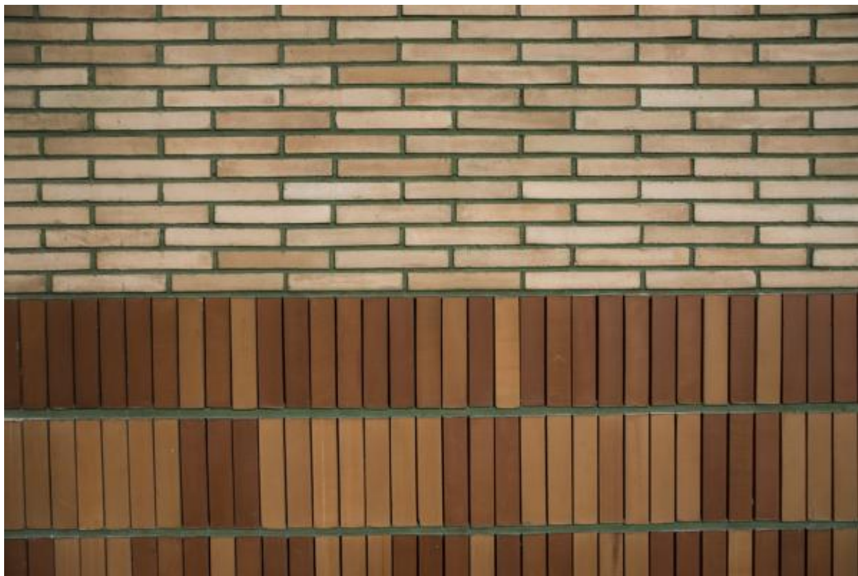
Vue des briques polychromes.
