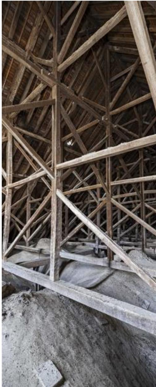
Vue d'une section de la charpente composée d'un poinçon, d'un entrait et de petits entrails.
