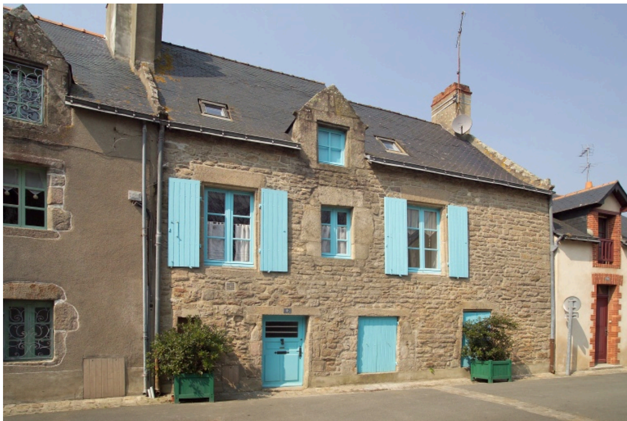
Vue de la façade sur rue.
