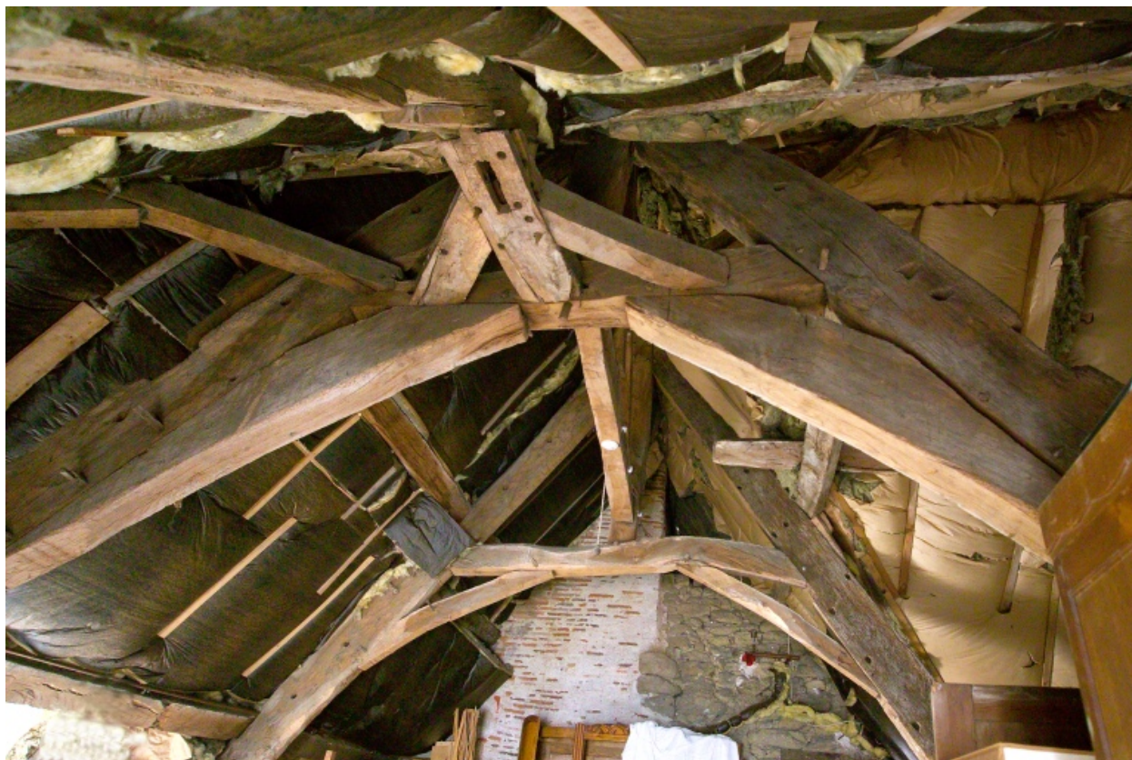
Vue de la charpente vers l'Ouest.
