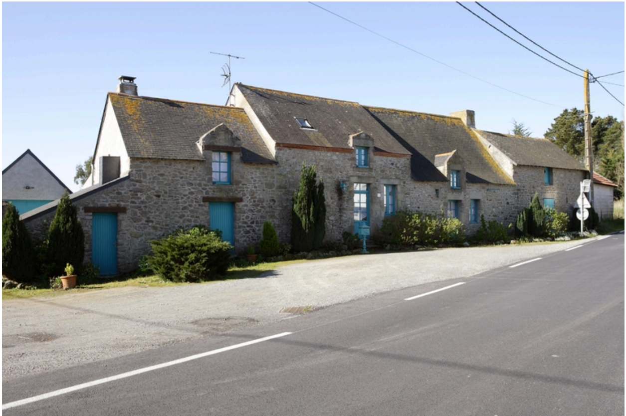
Vue d'ensemble de la rangée depuis le nord-est.
