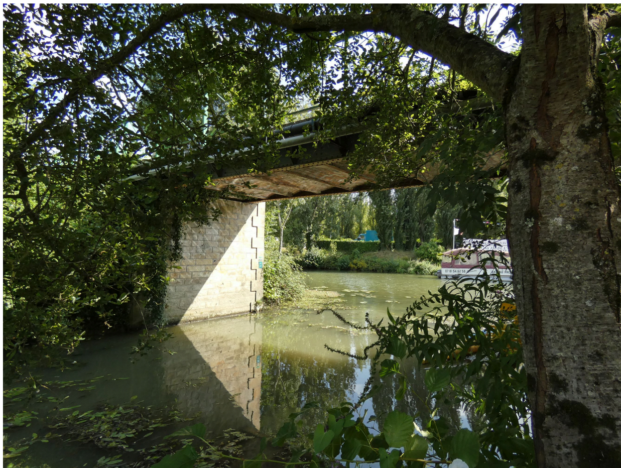
Le pont vu en amont, depuis le nord-ouest.
