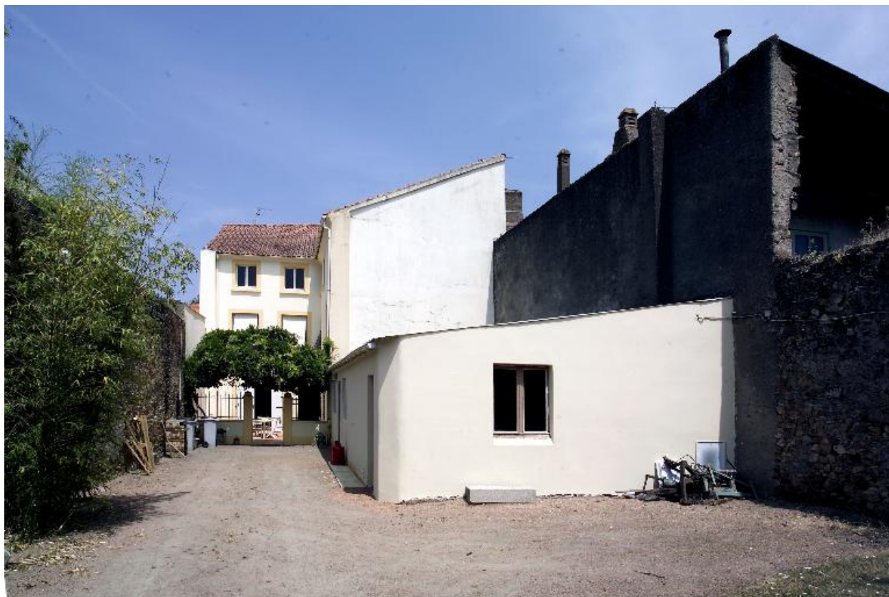
Vue d'ensemble depuis le jardin.
