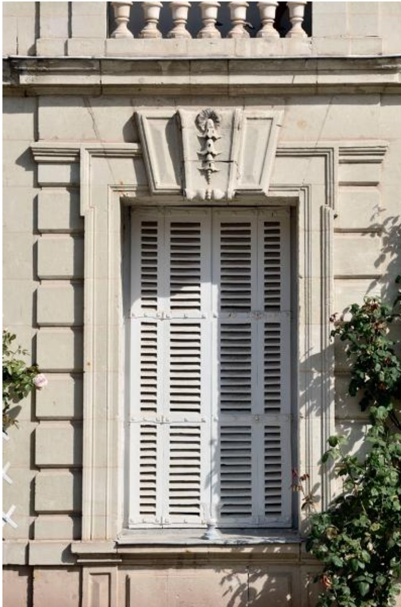
Les Vaults. Château. Façade sud. Détail de l'une des fenêtres du 1er étage.
