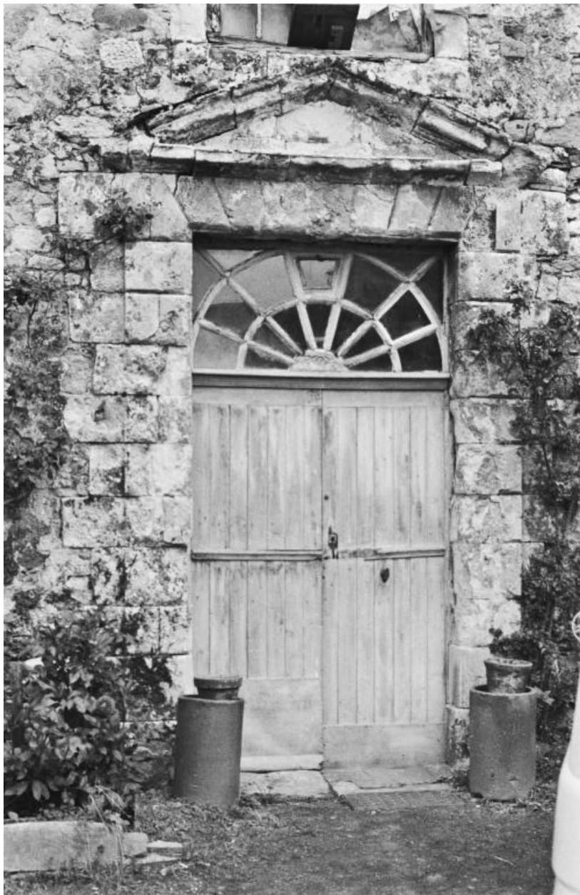
Détail de la porte d'entrée.
