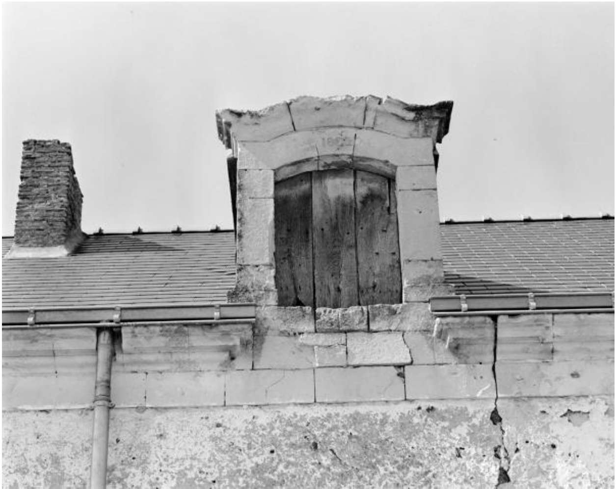
Façade antérieure, détail de la lucarne, 1985.
