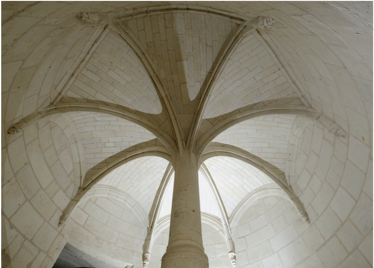
Vis Renaissance, intérieur : détail des doubleaux rayonnants du voûtement et du noyau traité en colonne à base attique.
