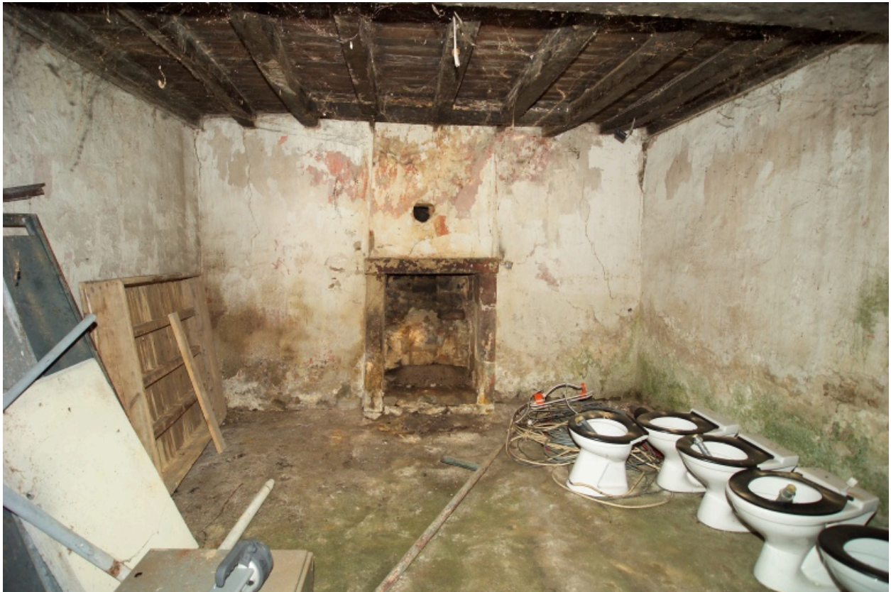
Bâtiment nord, intérieur salle nord.
