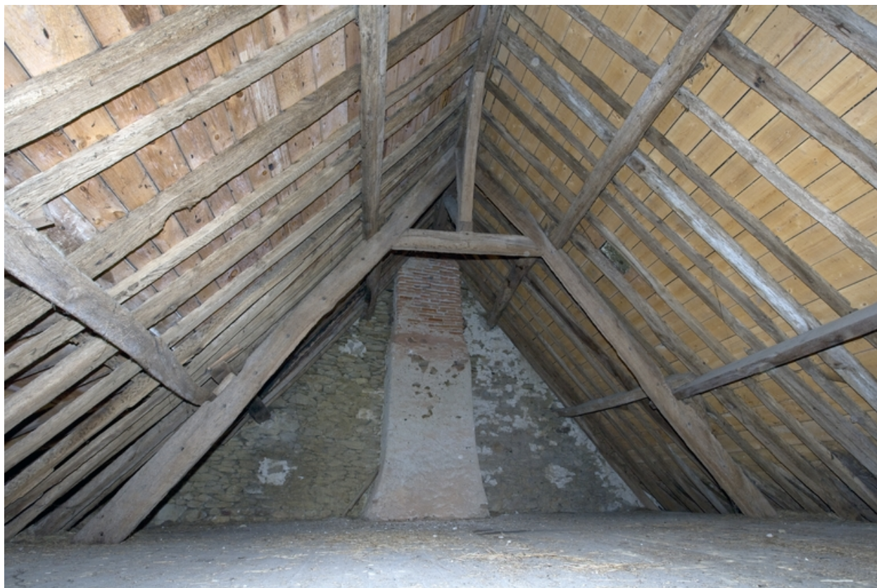
N° 10 rue Basse. Comble. Vue d'ensemble de la charpente.
