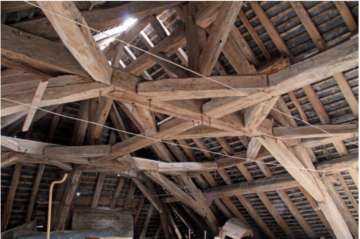
Logis, comble : charpente côté sud.
