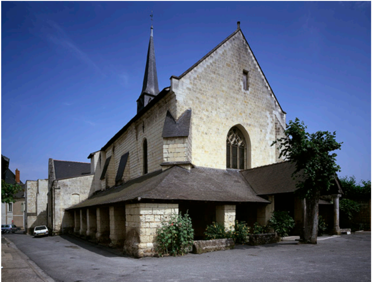
Vue générale (vue prise en 2000).
