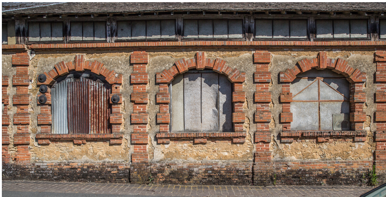
Un détail de la façade longeant la rue des Vieux-Ponts.
